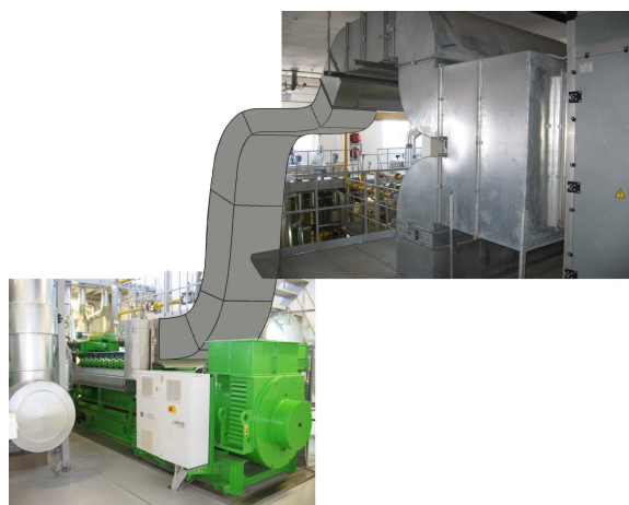
Рис. 5. Подача воздуха к приемному фильтру ГПД
