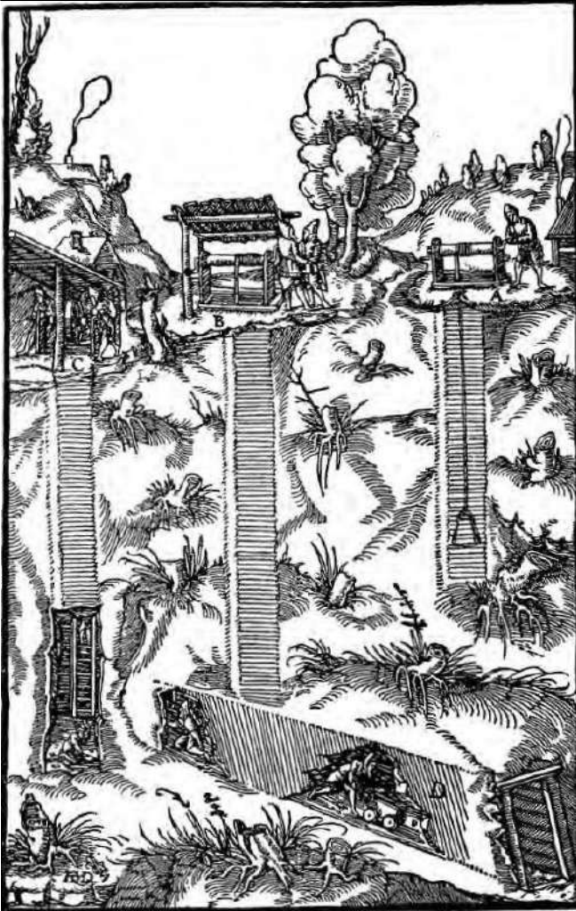
Рис. 5. Три вертикальні стволи шахт у напрямку до штольні на гравюрі з праці Георгія Аґріколи «Про гірничу справу та металургію» 1550 р.
