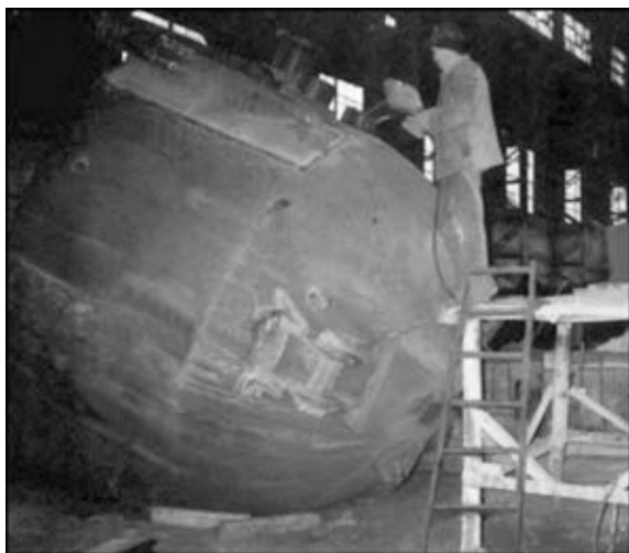
Рис. 6. Ремонтная сварка самозащитной порошковой проволокой металлургического оборудования на ПАО «Днепропетровский металлургический комбинат им. Ф. Э. Дзержинского»
