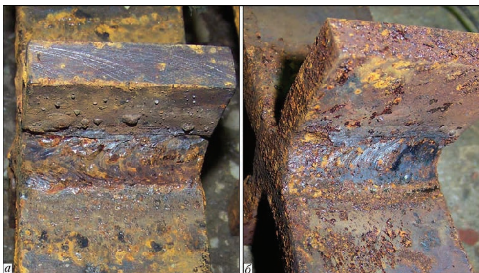
Рис. 7. Внешний вид зоны шва таврового сварного соединения в исходном (а) и упрочненном технологией ВМП (б) состояниях после выдержки на протяжении 1200 ч в условиях повышенной влажности и температуры
