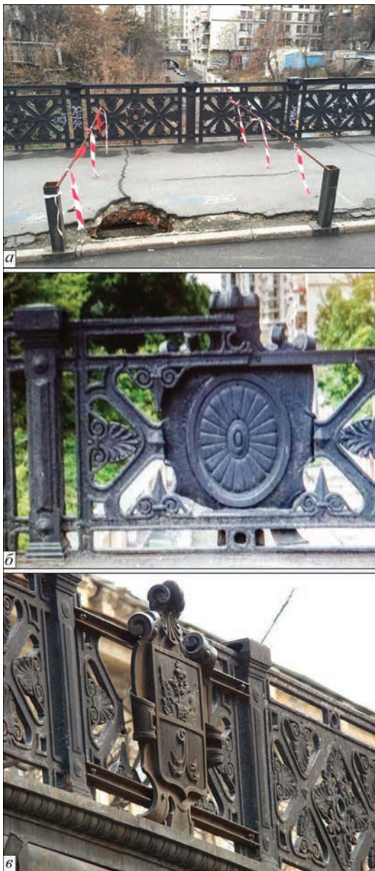
Рис. 2. Общий вид состояния перильного ограждения моста Коцебу в 2016 г. (до демонтажа): а — панорамный вид; б — тыльная сторона герба на подгербовой решетке; в — лицевая сторона герба на подгербовой решетке
