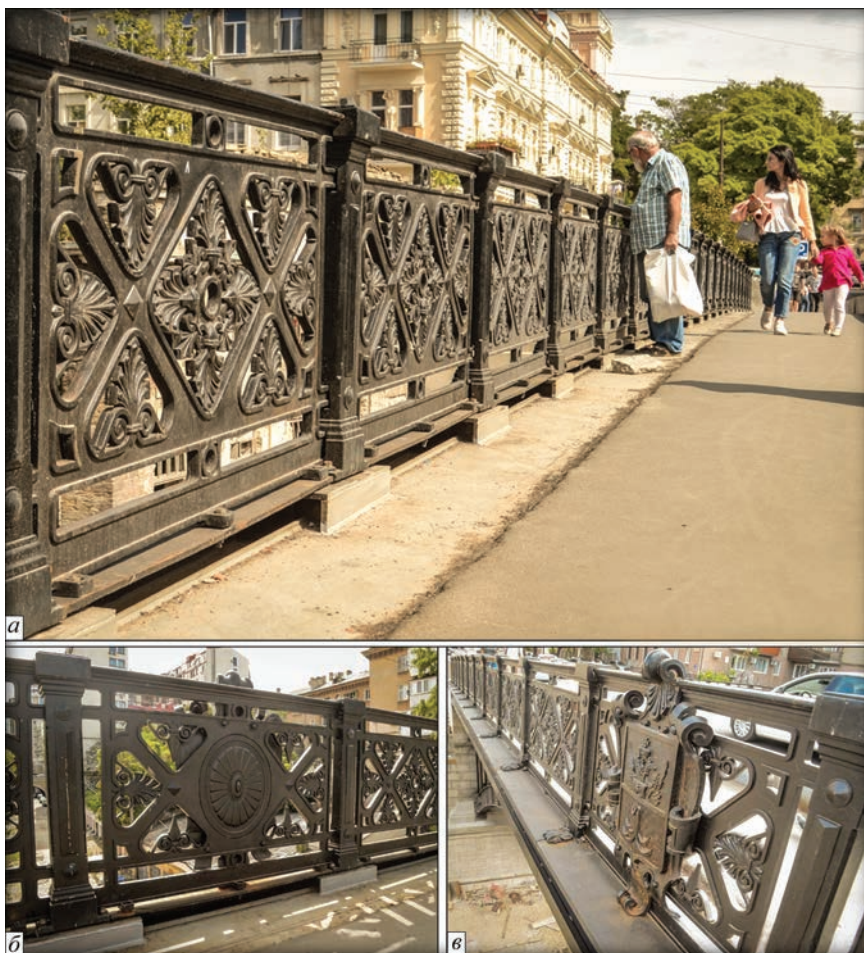
Рис. 6. Общий вид ансамбля перильного ограждения (август–сентябрь 2017 г.): а — вид обновленного панно решеток ограждения; б — подгербовая решетка с гербом (вид со стороны тротуара); в — вид с внешней стороны моста
