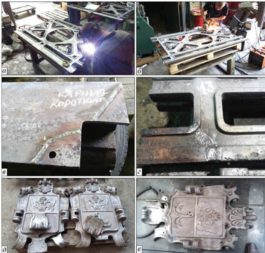
Рис. 5. Фрагменты реставрационных работ: а — реставрация сваркой подгербовой решетки; б — финишная зачистка сварных швов; в — вид ремонтного стыка на коротком карнизе; г — вид ремонтного стыка на решетке № 13; д — вид гербов до реставрации (на переднем плане вновь отлитые фрагменты утраченных украшений — волути); е — вид герба № 1 после реставрации
