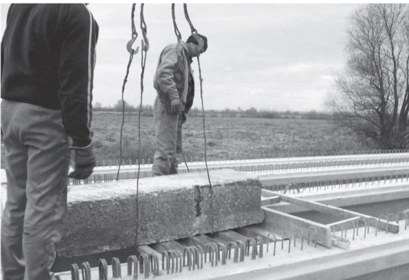
Рис. 5. Випробування фрагменту настилу бетонним блоком
