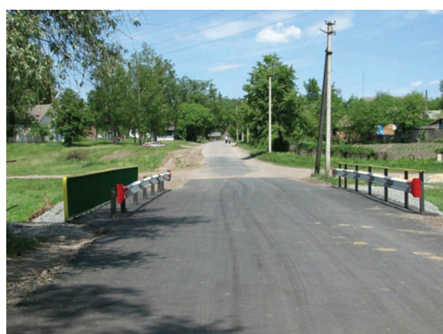
Рис. 2. Міст с. Веприк Гадяцького району після ремонту
