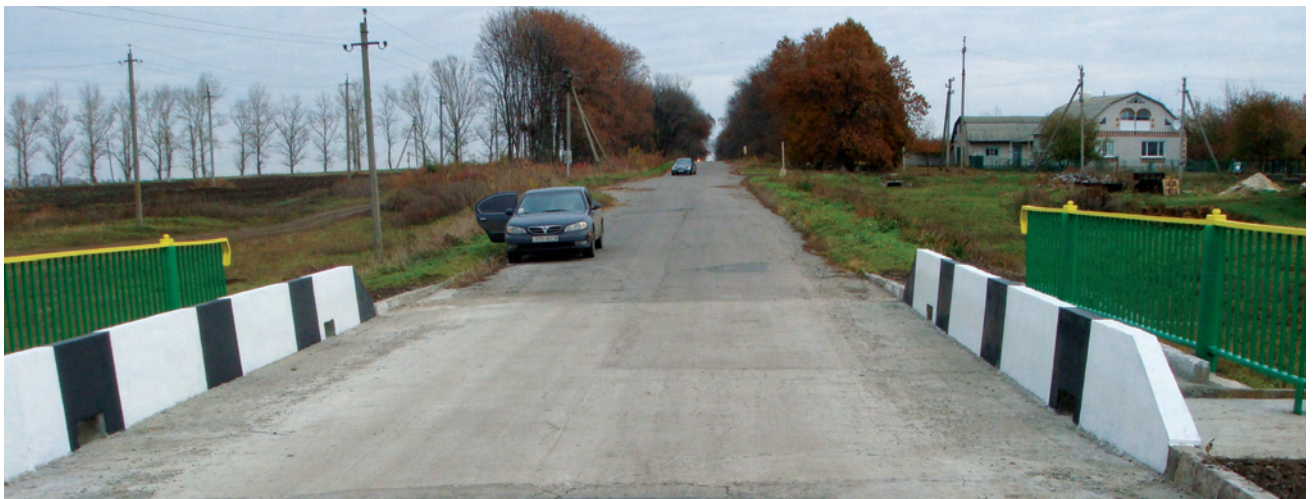
Рис. 4. Міст с. Степне Полтавського району після ремонту
