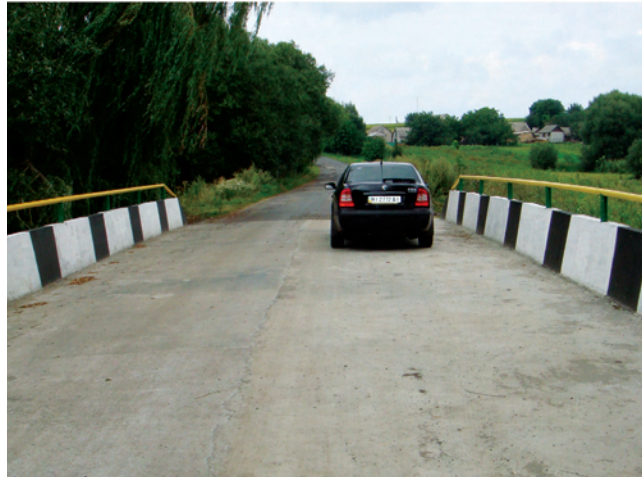
Рис. 6. Міст с. Вільниця Чутівського району після ремонту
