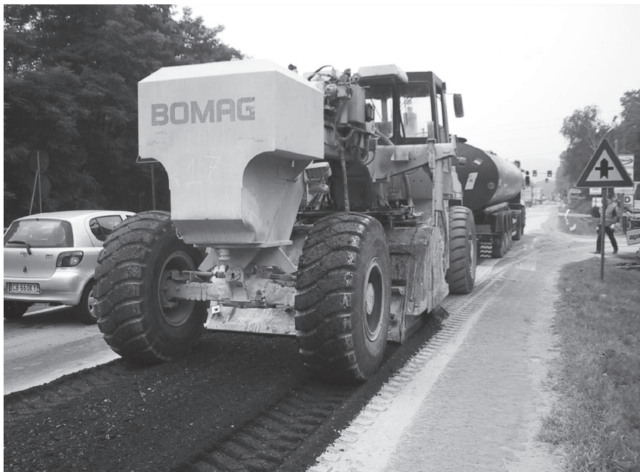
Рис. 1. Застосування технології холодного ресайклінгу старих шарів дорожнього одягу нежорсткого типу в Італії
