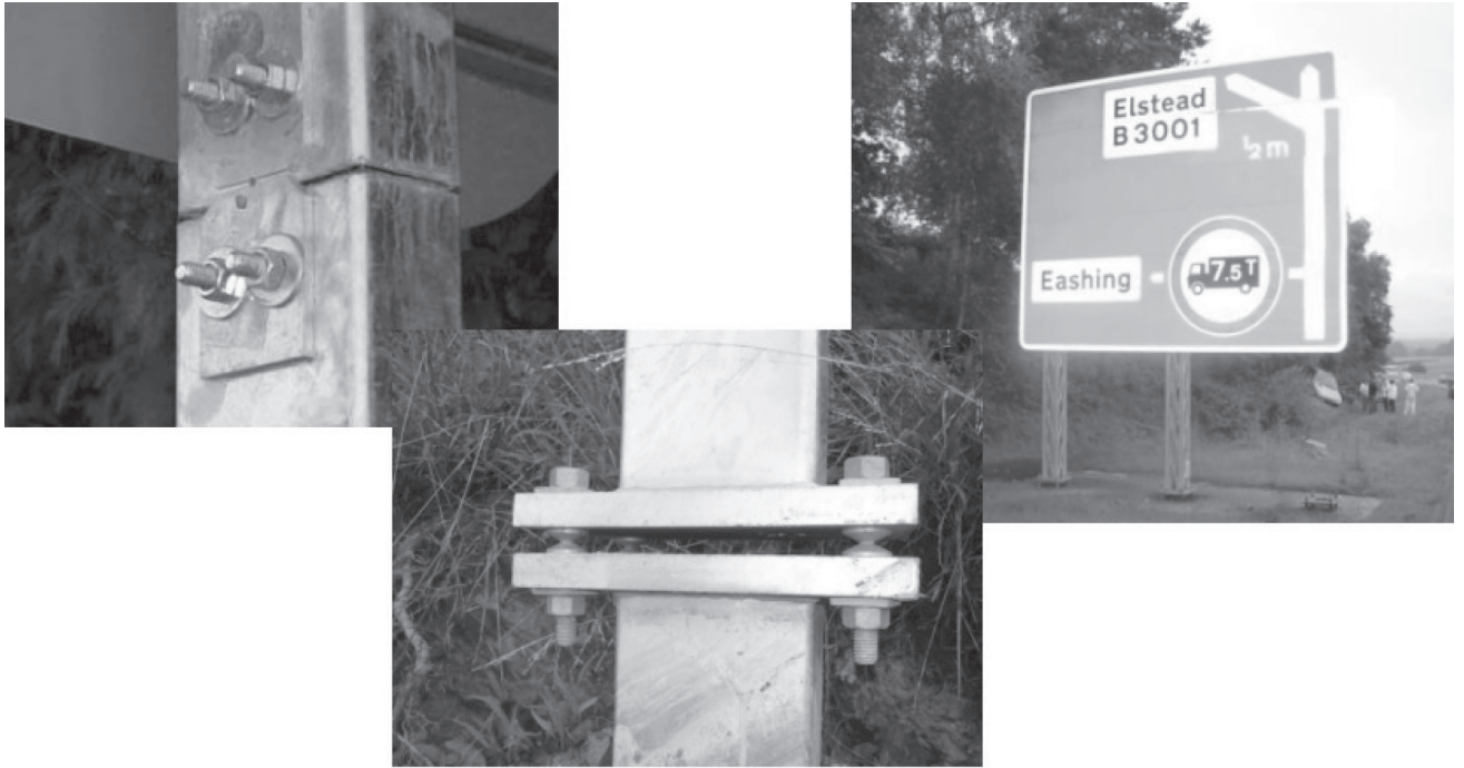
Рис. 4. Загальний вигляд зчленування по висоті пасивно безпечних опорних елементів під дорожні знаки
