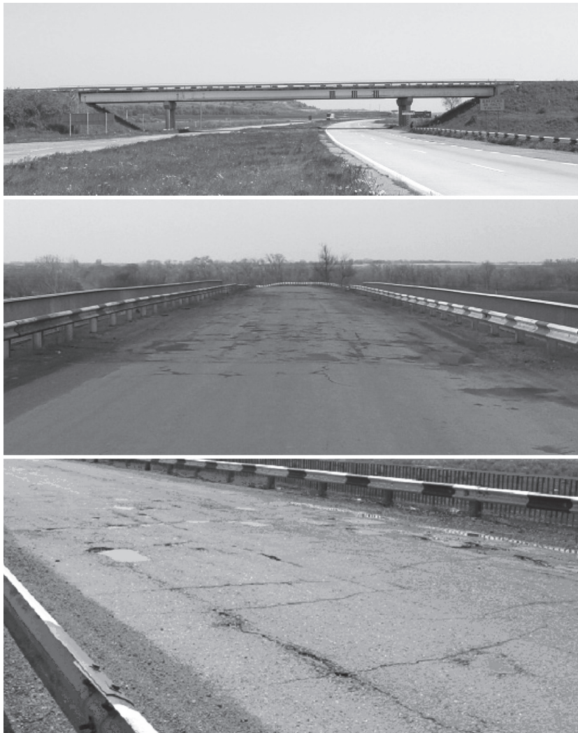
Рис. 2. Залізобетонний шляхопровід з нерозрізною балковою прогоновою будовою за схемою 15+42+15 та його проїзна частина
