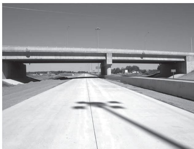
Рис. 3. Цементобетонное покрытие автомобильной дороги
