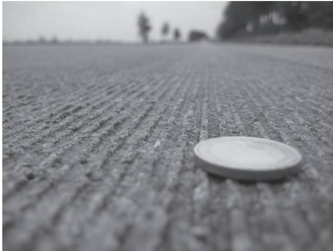
Рис. 4. Асфальтобетонное покрытие автомобильной дороги
