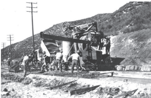
Рис. 1. Строительство дороги с жестким покрытием вторая половина 19 века
