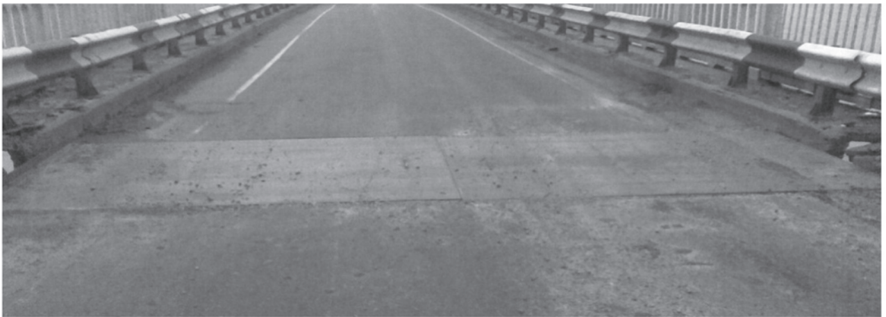
Рис. 4. Влаштований деформаційний шов гравітаційного типу
