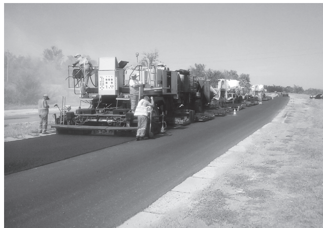
Рис. 1. Відновлення асфальтобетонного покриття за технологією гарячого ресайклінгу на автомобільній дорозі спеціалізованою технікою
