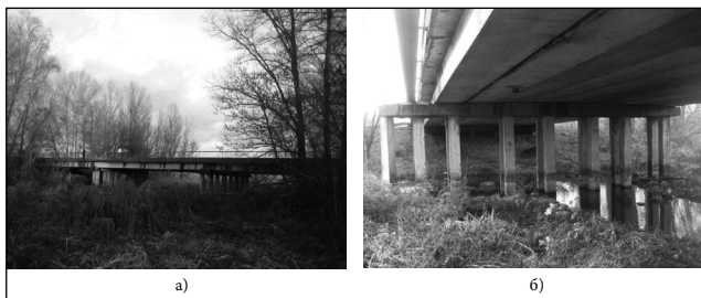
Рис. 1. Загальний вигляд моста
