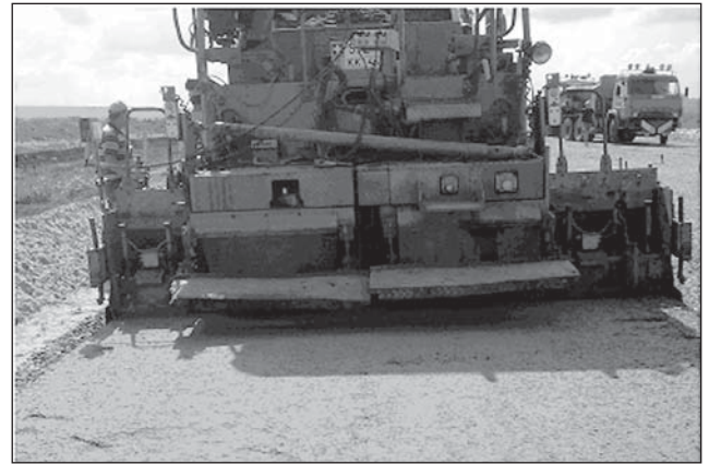
Рис. 1. Укладання пісної бетонної суміші асфальтоукладальником
