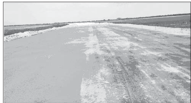
Рис. 6. Ділянка основи з пісного укоченого бетону на дорозі 2 категорії в Курській області
