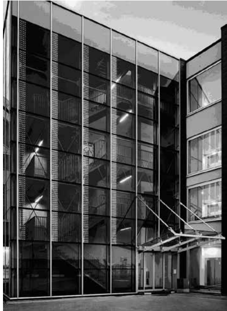
Рис. 4. Між поверхнями скляних подвійних фасадів можуть встановлюватися світлоелементи у формі відбивачів або голографічних модулів
