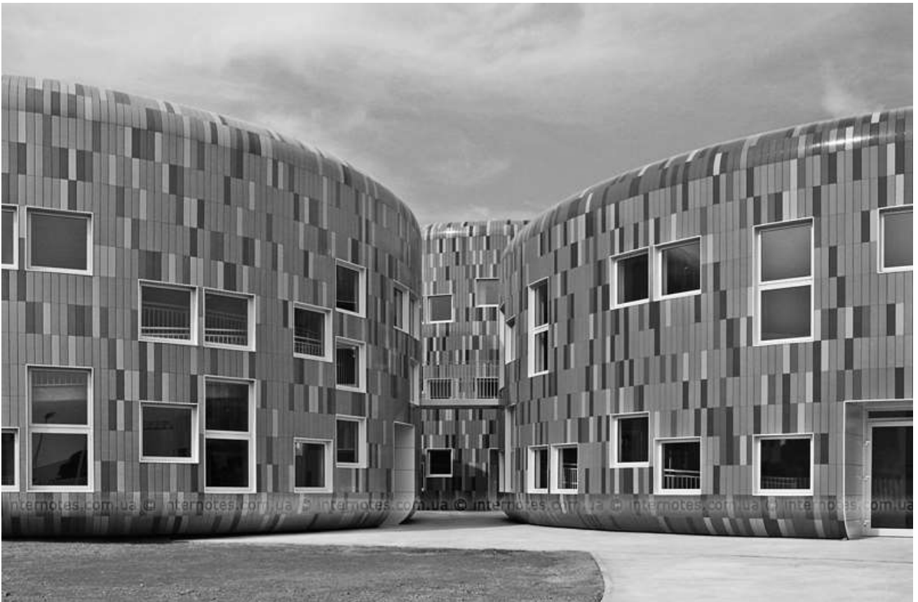
Рис. 5 Будівля мерії в Лондоні, арх. Н. Фостер, 2001р.
