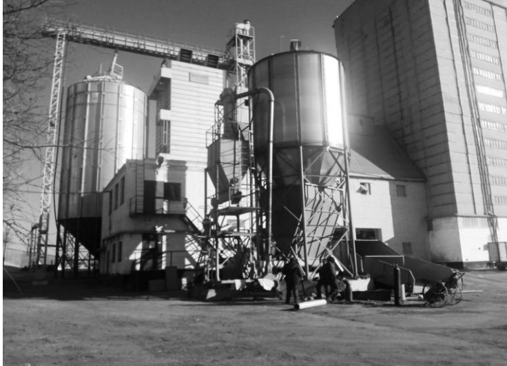
Рис.1. Модернізована сушильна установка.
