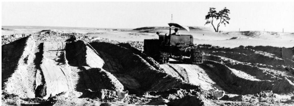
Початок будівництва заводу. 30-ті роки ХХ ст. Фото з Народного музею історії ПрАТ “Северодонецьке об’єднання Азот”.
