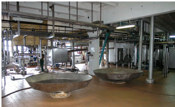
Рис. 18. Монтаж бродильних чанів з конічним дном фірми Steinecker
