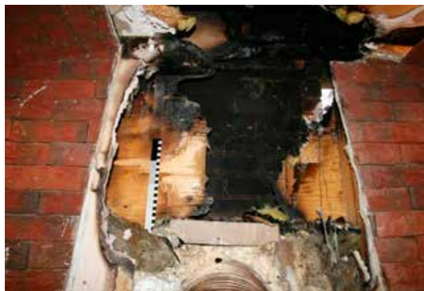
Ryc. 29, 30. Zwęglenia w wyniku pirolizy okapu i czopucha kominaka wykonanego ze sklejki (fot. Tomasz Wiśniewski) Fig. 29, 30. Charring caused by pyrolysis of fireplace hood and flue made of plywood (photos by Tomasz Wiśniewski)
