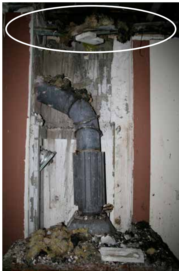
Ryc. 9, 10. Widok śladów ognia nad czopuchem (fot. Tomasz Wiśniewski) Fig. 9, 10. Picture showing traces of fire above the flue (photos by Tomasz Wiśniewski)
