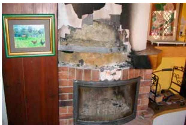
Ryc. 27, 28. Zwęglenia w wyniku pirolizy tzw. okapów kominków wykonanych z płyty wiórowej z naturalną okleiną (fot. Tomasz Wiśniewski)
