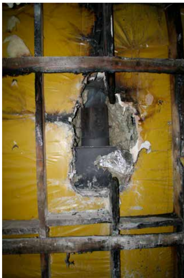
Ryc. 31, 32. Widok kominaka, którego ściana tylna została wykonana w konstrukcji szkieletowej z elementów drewnianych a przewody dymowe zostały poprowadzone w odległości 3 cm od tej konstrukcji (fot. Tomasz Wiśniewski) Fig. 31, 32. Picture of a fireplace, whose rear wall frame was constructed from wooden elements and smoke ducts were routed at a distance of 3 cm from this structure (photos by Tomasz Wiśniewski)
