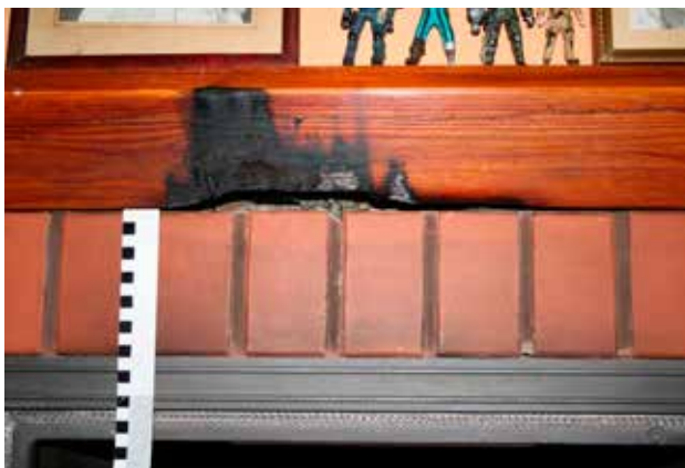
Ryc. 29, 30. Zwęglenia w wyniku pirolizy okapu i czopucha kominaka wykonanego ze sklejki (fot. Tomasz Wiśniewski) Fig. 29, 30. Charring caused by pyrolysis of fireplace hood and flue made of plywood (photos by Tomasz Wiśniewski)
