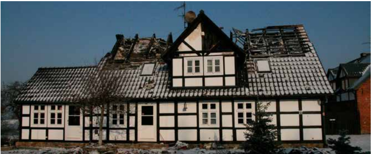
Ryc. 21. Widok budynku (fot. Tomasz Wiśniewski) Fig. 21. View of the bulding (photo by Tomasz Wiśniewski)
