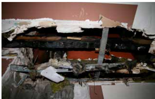
Ryc. 11, 12. Widok śladów ognia nad czopuchem (fot. Tomasz Wiśniewski) Fig. 11, 12. Picture showing traces of fire above the flue (photos by Tomasz Wiśniewski)
