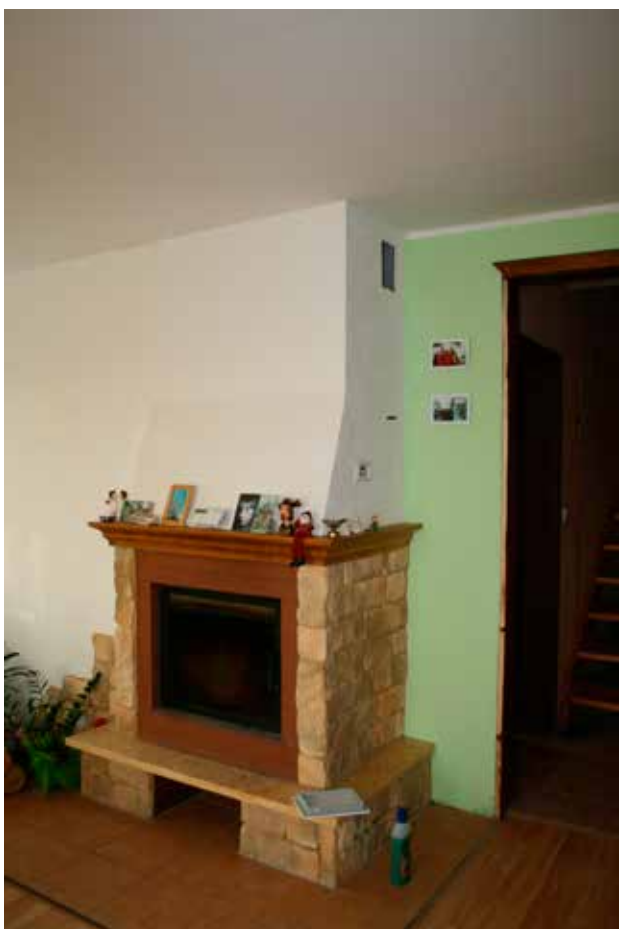
Ryc. 31, 32. Widok kominaka, którego ściana tylna została wykonana w konstrukcji szkieletowej z elementów drewnianych a przewody dymowe zostały poprowadzone w odległości 3 cm od tej konstrukcji (fot. Tomasz Wiśniewski) Fig. 31, 32. Picture of a fireplace, whose rear wall frame was constructed from wooden elements and smoke ducts were routed at a distance of 3 cm from this structure (photos by Tomasz Wiśniewski)
