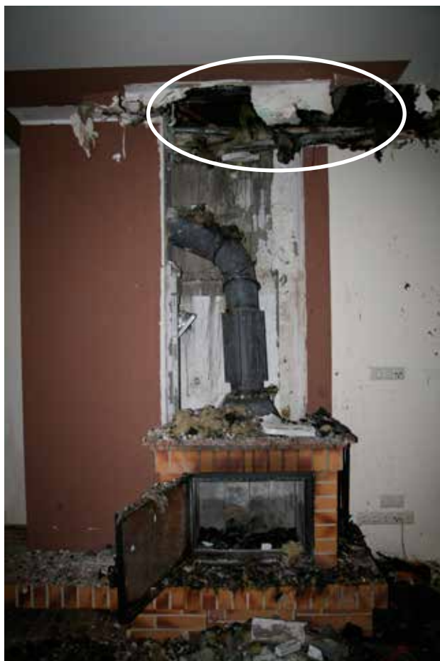
Ryc. 9, 10. Widok śladów ognia nad czopuchem (fot. Tomasz Wiśniewski) Fig. 9, 10. Picture showing traces of fire above the flue (photos by Tomasz Wiśniewski)
