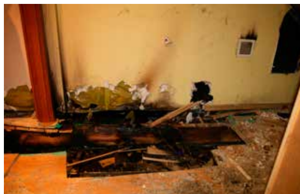
Ryc. 11, 12. Widok śladów ognia nad czopuchem (fot. Tomasz Wiśniewski) Fig. 11, 12. Picture showing traces of fire above the flue (photos by Tomasz Wiśniewski)
