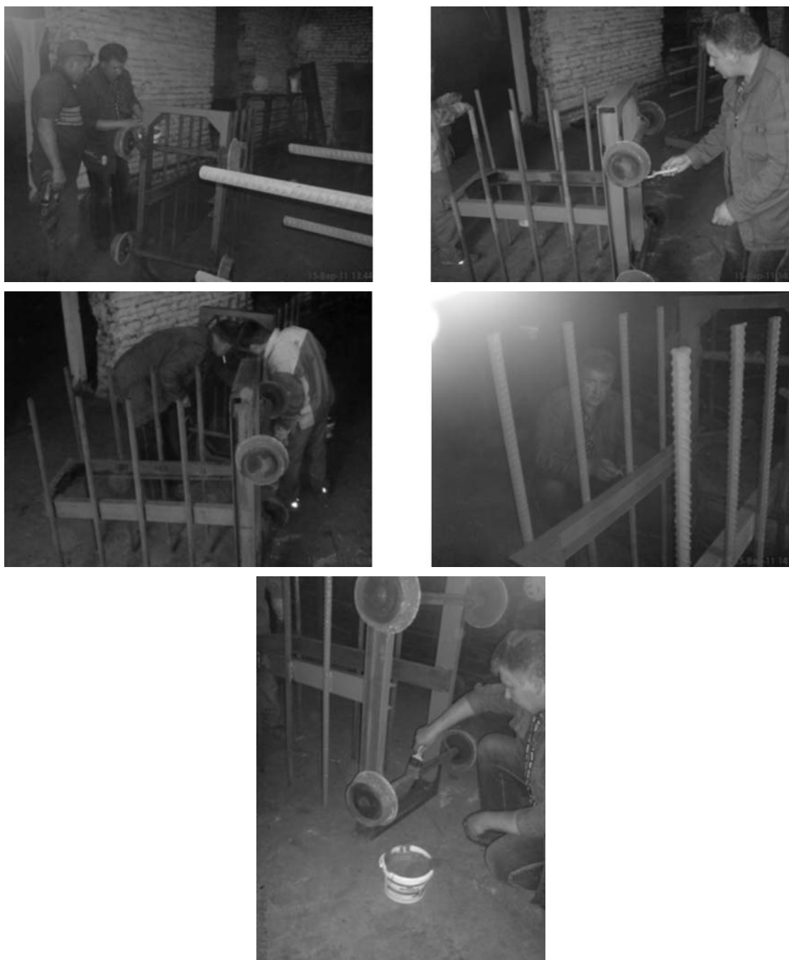
Рисунок 3 – Выполнение работ по антикоррозионной защите сушильных вагонеток
