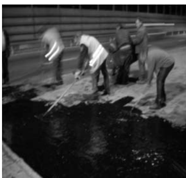
Рисунок 9 - Технологія нанесення гідроізоляції "Ребіт" на ортотропну плиту вручну валиками
