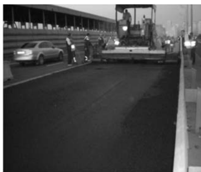
Рисунок 10 - Технологія укладання та ущільнення асфальтобетонної суміші
