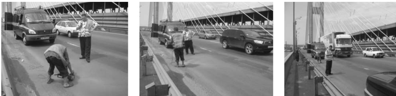
Рисунок 4 - Стан дорожнього покриття на ортотропній плиті ПМП
