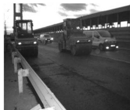
Рисунок 10 - Технологія укладання та ущільнення асфальтобетонної суміші
