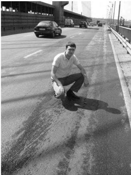
Рисунок 1 - Поздовжні тріщини
