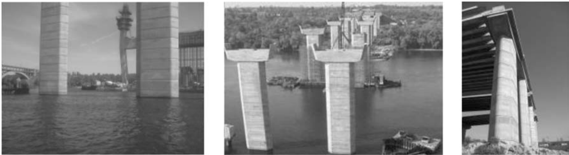
Рисунок 2 – Строительство мостовых переходов через реку Днепр (Запорожье)
