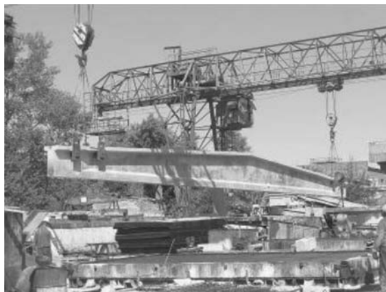
Рисунок 5 - Производство 30-метровых балок перекрытия на ЗАО «ЗЖБК №1» (Запорожье)
