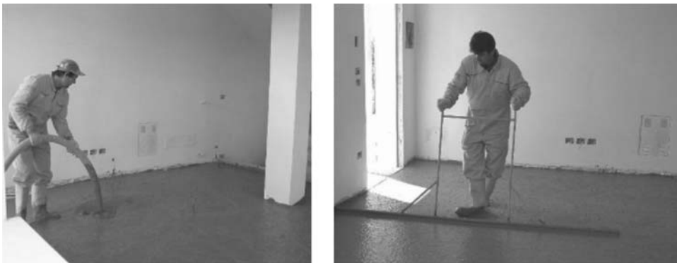
Рисунок 1 - Наливные полы помещения завода «Преобразователь» (Запорожье)
