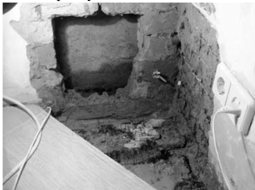
Фото 2 - Устройство гидроизоляции по принципу «фальш-стены»
