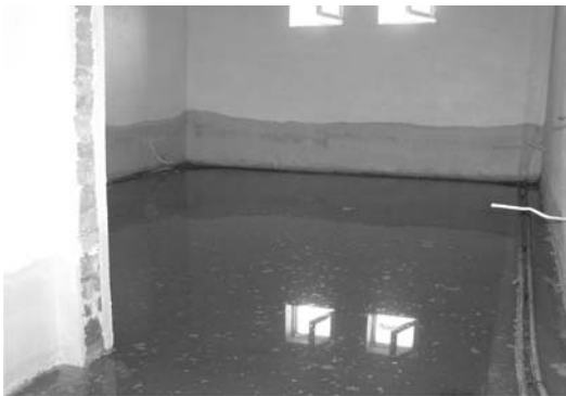
Фото 5 - «Отказ работы гидроизоляции из-за изменения водных нагрузок
