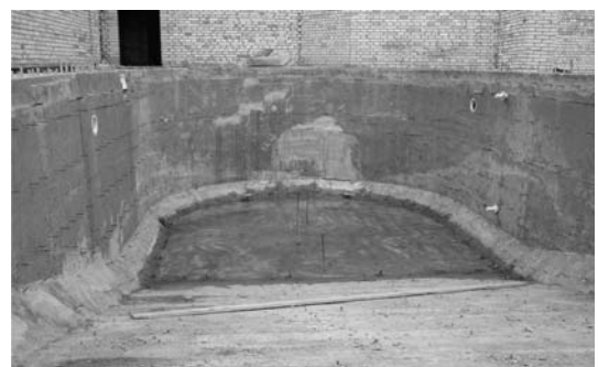
Фото 1 - Устройство гидроизоляции бассейна
