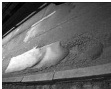
Рисунок 2 - Автодорожній міст метро через р. Дніпро, обстеження - 2010 р.
