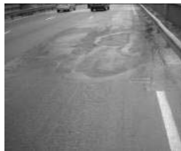
Рисунок 3 - Південний мостовий перехід (естакадна частина), обстеження - 2011 р.
