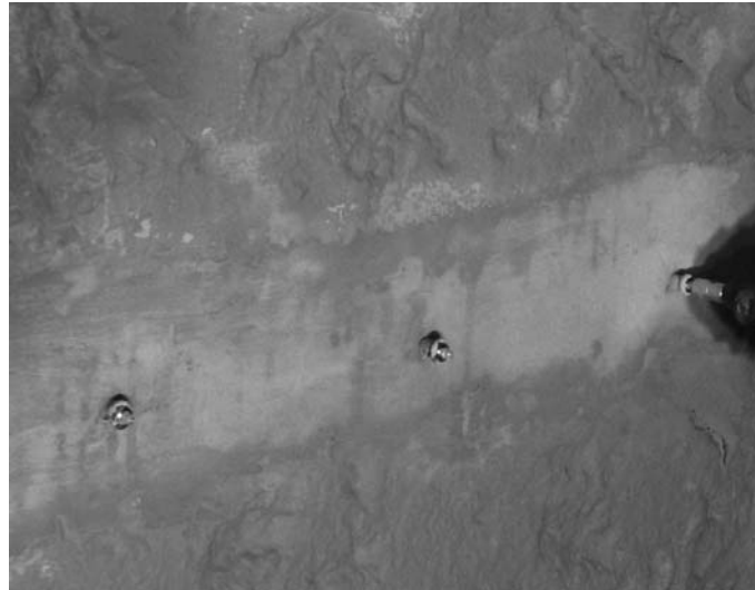
Рисунок 4 - Ділянка стіни насосної станції, підготовленої для ін'єктування
