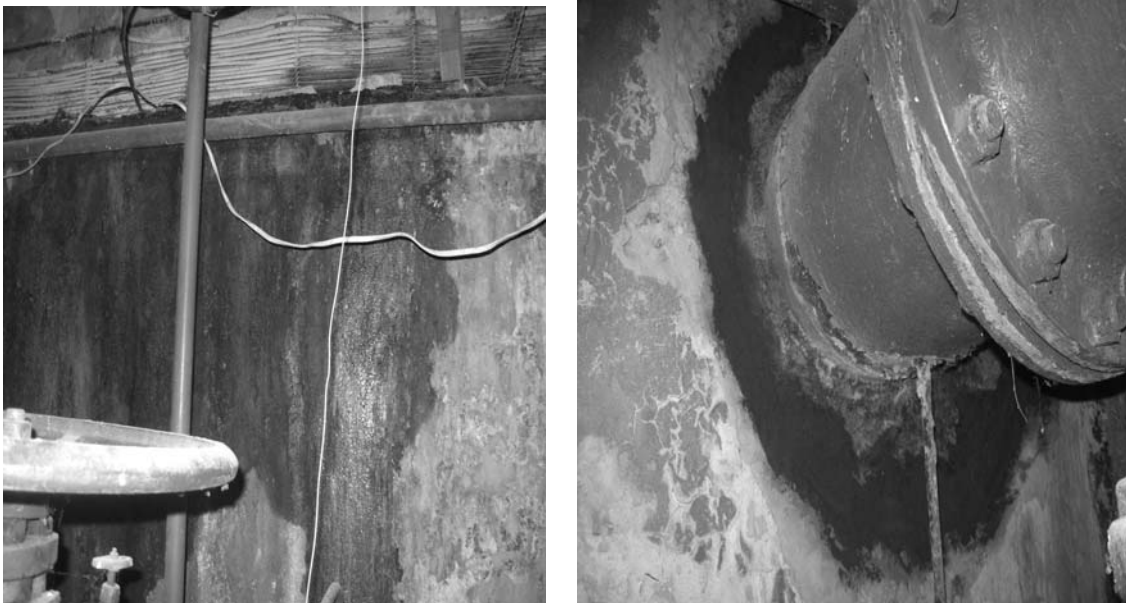
Рисунок 2 - Зони активної фільтрації води на Кочурській насосній станції
