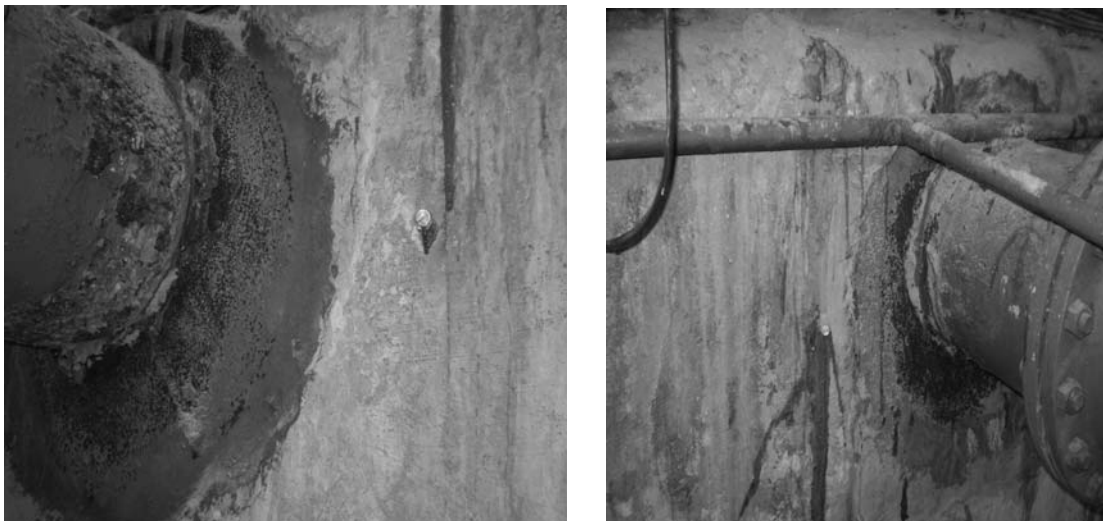
Рисунок 5 – Відремонтовані ділянки насосної станції
