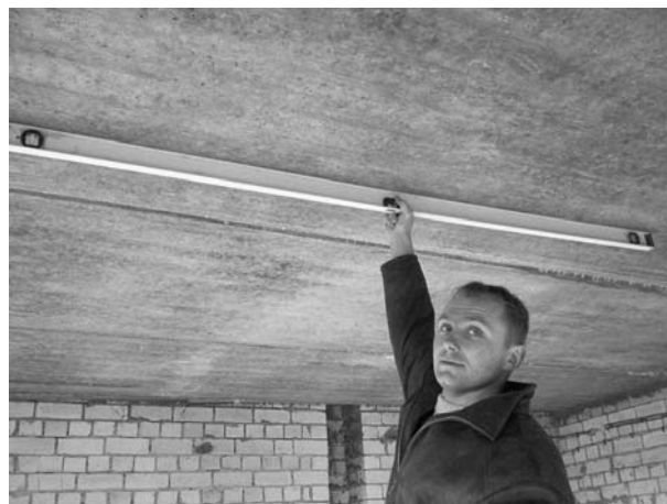
Рисунок 1 – Стеля із високоякісних плит перекриття безопалубного формування ПАТ «Чернігівський «Домобудівник» після облаштування стиків готова до пофарбування або наклеювання шпалер
