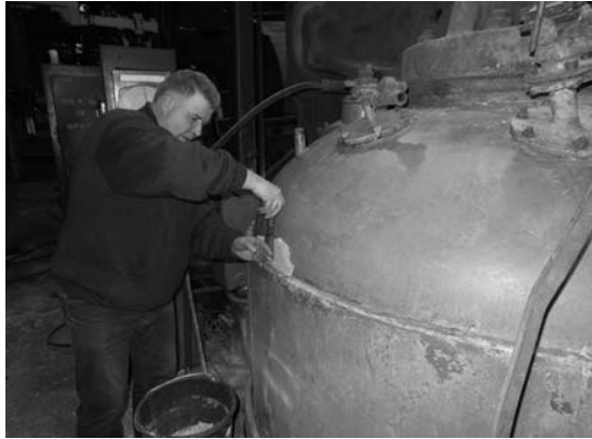
Рисунок 3 - Выполнение работ по теплоизоляции сферического сектора верхней паровой камеры форматора-вулканизатора 88'' №4/9: нанесение праймера на основе геоцемента (а); приготовление теплоизоляционного покрытия (б); нанесение теплоизоляционного покрытия (в, г)
