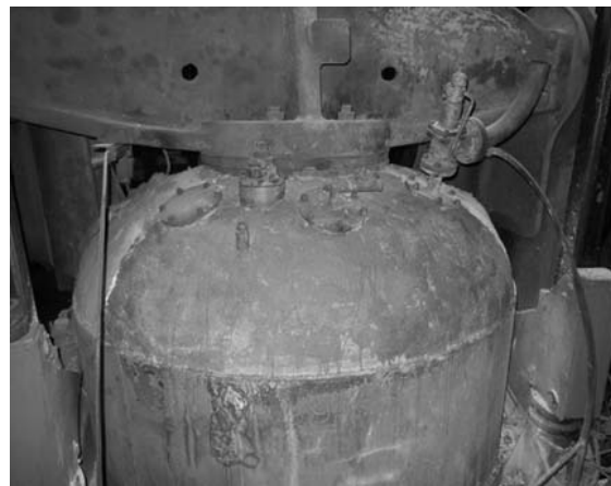
Рисунок 4 - Нанесение геоцементного праймера на поверхность теплоизоляционного покрытия
