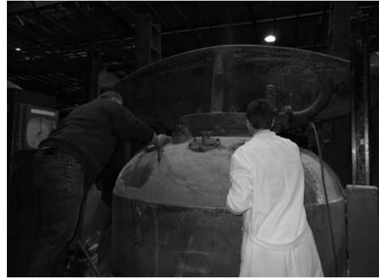
Рисунок 3 - Выполнение работ по теплоизоляции сферического сектора верхней паровой камеры форматора-вулканизатора 88'' №4/9: нанесение праймера на основе геоцемента (а); приготовление теплоизоляционного покрытия (б); нанесение теплоизоляционного покрытия (в, г)
