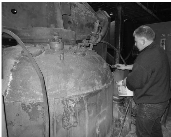
Рисунок 4 - Нанесение геоцементного праймера на поверхность теплоизоляционного покрытия
