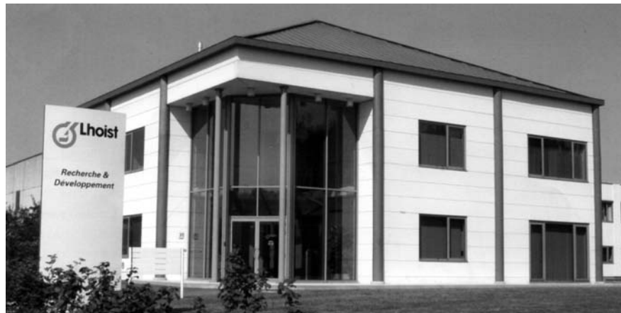
Рисунок 4 – Здание офиса со стенами из газобетонных панелей
