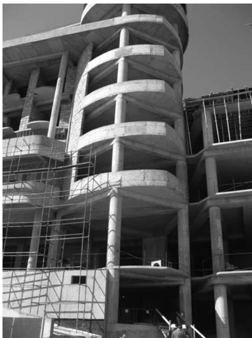
Рисунок 1 - Здание климатопа- вильона со стенами из блоков газобетона
