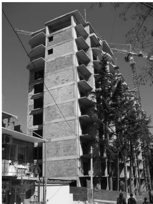
Рисунок 2 - Здание спального корпуса со стенами из блоков газобетона
