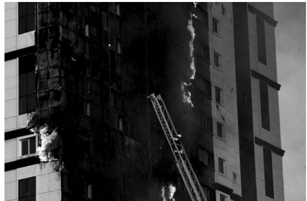
Рисунок 2. Фрагмент фасаду вежі «Олімп» під час пожежі
