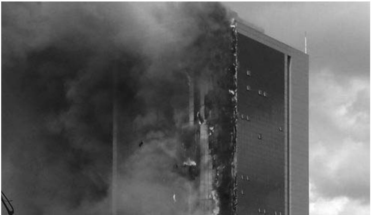
Рисунок 4. Стамбул. Пожежа на висотній будівлі.
