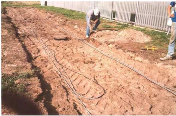
Рис. 3. Гідравлічний засіб виявлення «Ground Perimeter System МРК40»: закладання гідравлічних шлангів, приклади сенсорів та компенсційних клапанів
