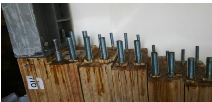
б) вид разрушения соединений
