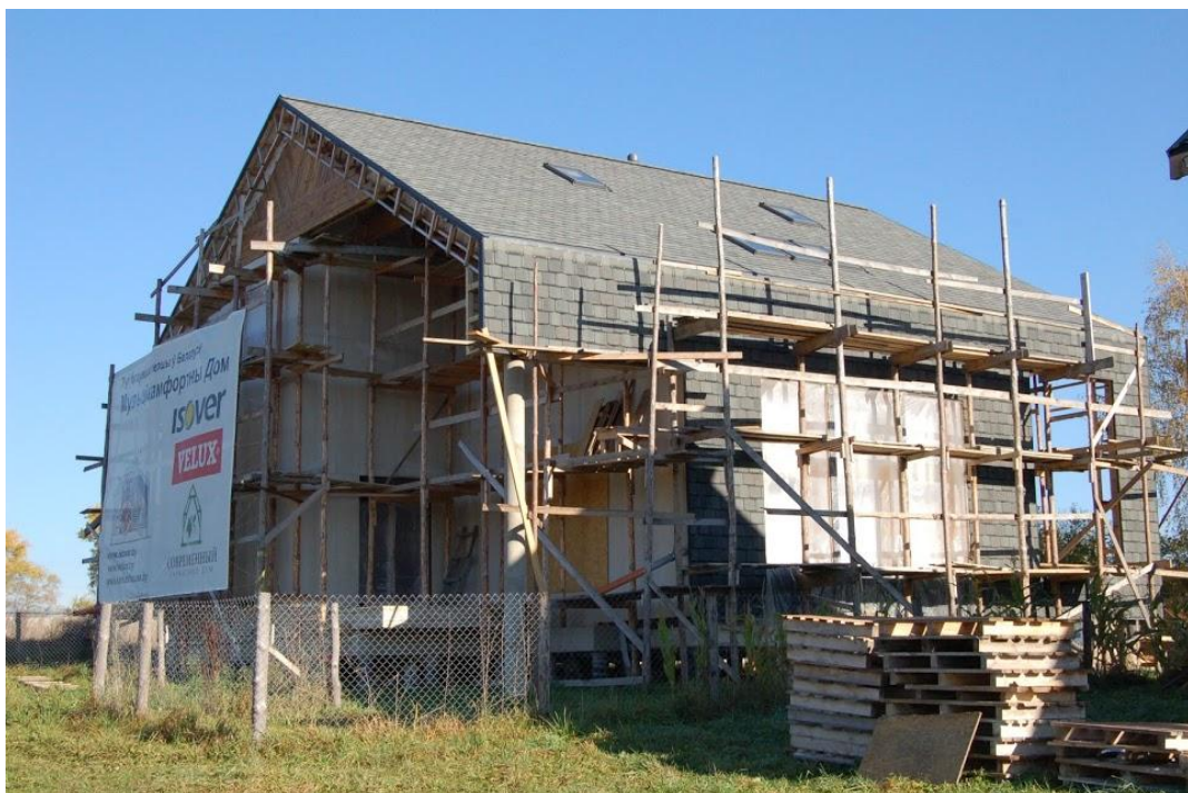
Рис.5. Вид с юго-запада
