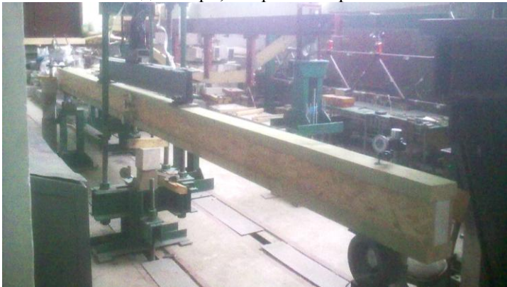
Рис. 2. Загальний вигляд випробувального стенду (балка Б-2)
