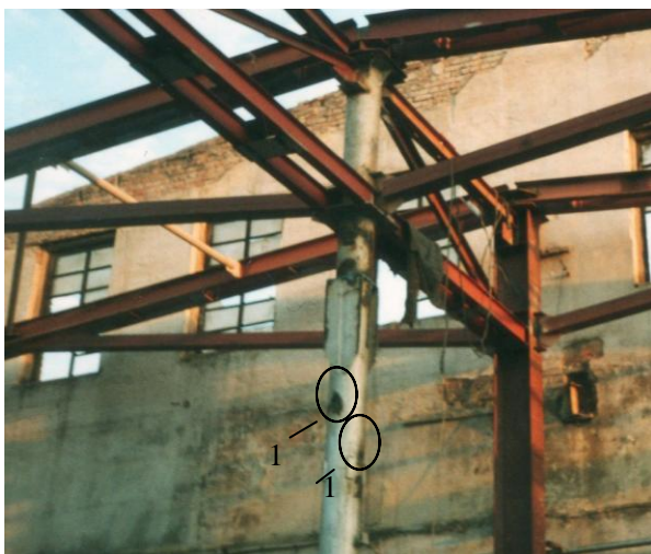
Рис. 2. Повторне використання сталевих труб, бувших у вжитку, у якості оболочкі трубобетонних стійок при новому будівництві:
