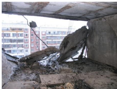
Рис. 2. Состояние несущих конструкций здания после взрыва
