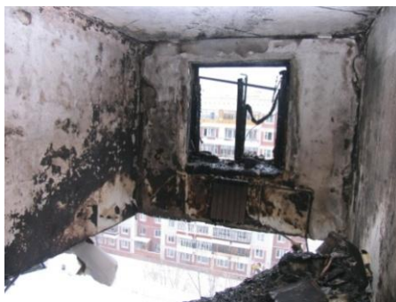
Рис.3 Фрагменты разрушенных участков перекрытий
