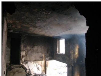
Рис. 2. Состояние несущих конструкций здания после взрыва
