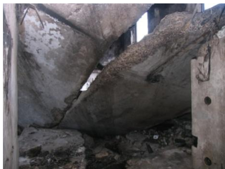
Рис.3 Фрагменты разрушенных участков перекрытий
