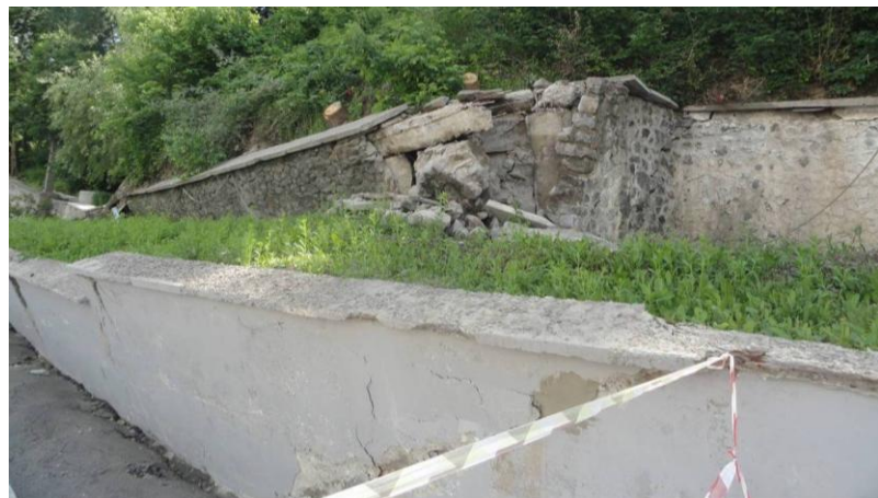
Рис. 2. Видгляд території після зсуву: a – у верхній частині схилу; б – у нижній частині схилу
