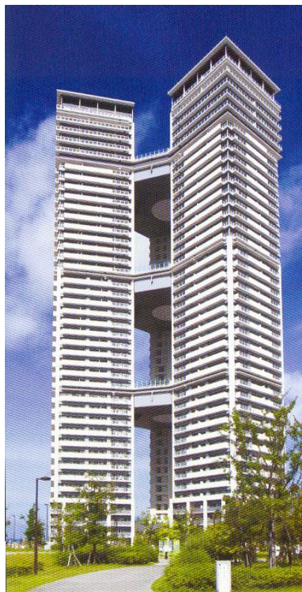
Рис. 2. Здание «Island Tower Sky Club»
