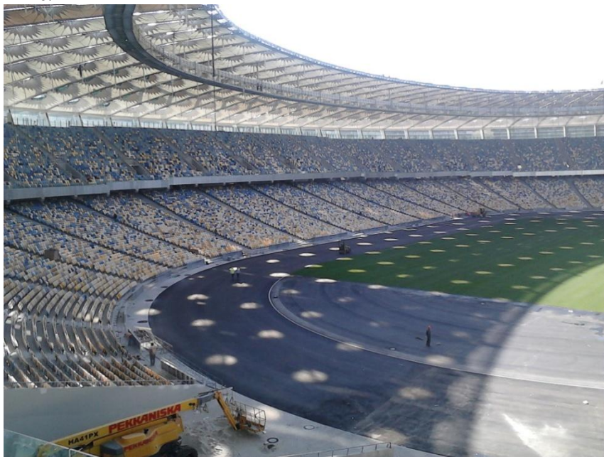
Рис. 2. Общий вид трибун и вантового покрытия на завершающем этапе работ
