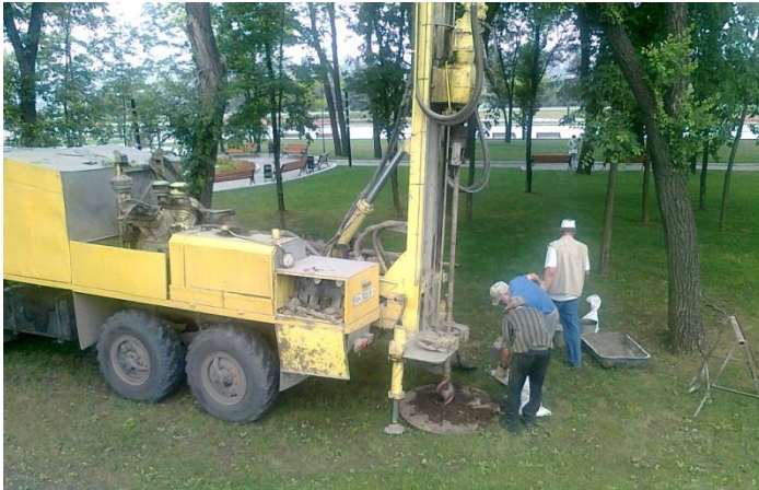
Рис. 1. Процесс закладки глубинных реперов
