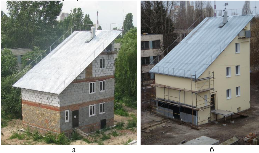
Рис. 2. Зовнішній вигляд експериментального будинку пасивного типу на стадії його будівництва до (а) та після (б) термомодернізації
