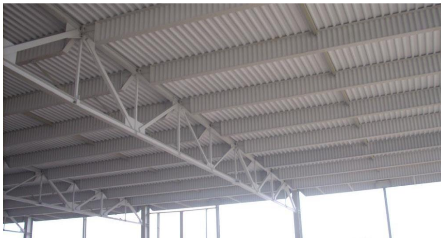
Рис. 2. Конструктивне рішення сполучення SIN-балочних прогонів із наскрізними ригелями
