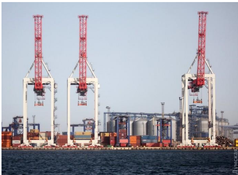
Рис. 1. Сочетание зданий, строений, сооружений, механизмов, расположенных на территории морского порта
