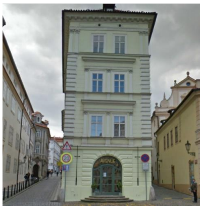
Рис. 3. Исторический жилой дом в центре Праги на улице. Влашской,4. Прибор DruPol установлен при общей реконструкции здания.
