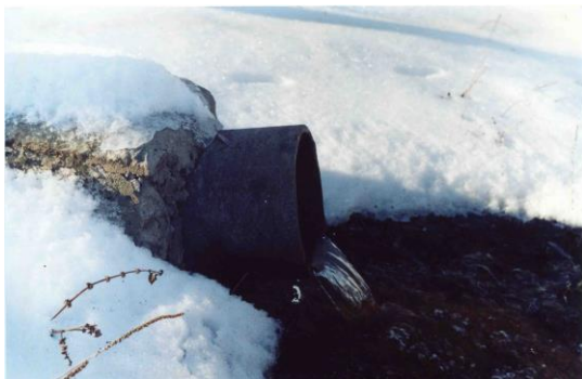
Рис. 2. Вытекание струи подземной воды из дренажной трубы в р. Мокрая Московку
