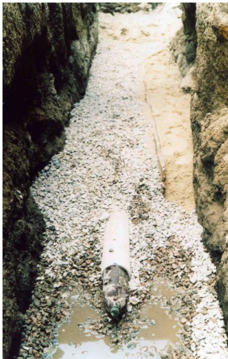
Рис. 1. Фрагмент устройства дренажной системы
