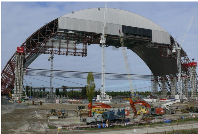
Рис. 1. Арка НБК с затяжками для восприятия распора в процессе строительства
