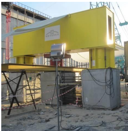
Рис. 3: Натуральный вид установки для испытания сваи вдавливанием
