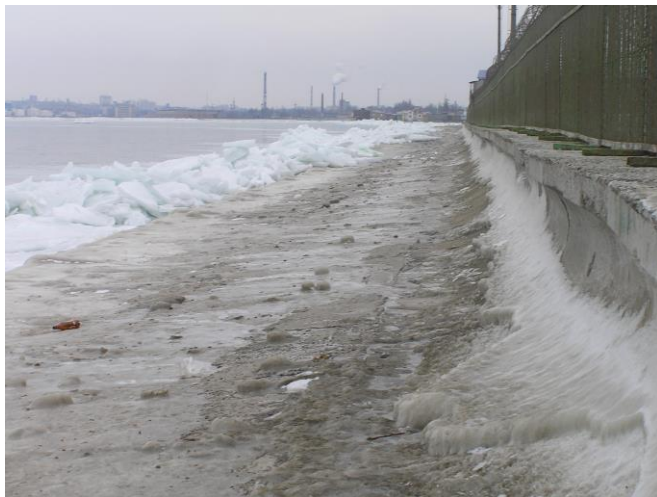
Рис. 2. Воздействие ледовых образований на берегозащитное сооружение
