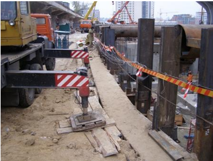
Рис. 5. Розміщених виносних опор крану біля краю котловану
