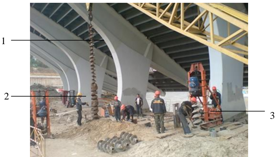
1-пілон трибуни верхнього ярусу, 2- шнекова колона, 3- бурова установка РБУ-2М
