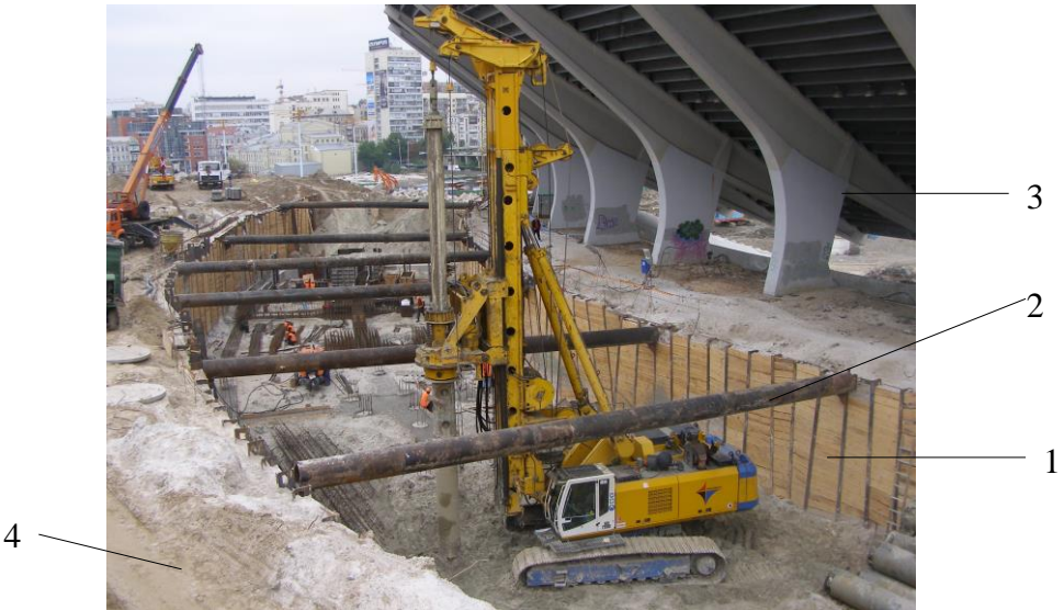
1- шпунтове огороження котловану, 2- розпірка, 3- пілон трибуни верхнього ярусу, 4- об'їздна дорога
