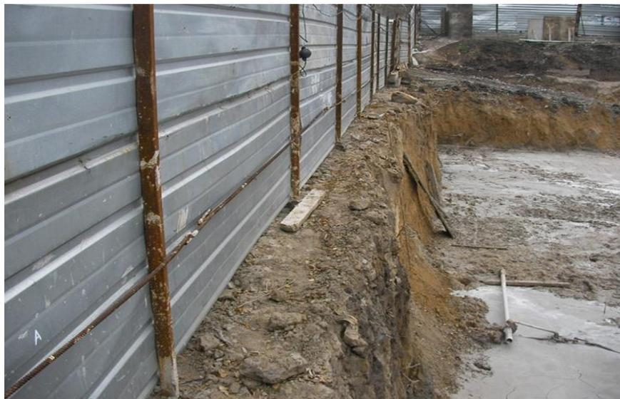
Рис. 3. Совмещение крепления бортов котлована с его ограждением
