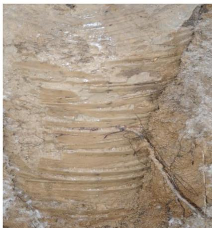
Рис. 5. Поверхность грунтоцементных элементов
