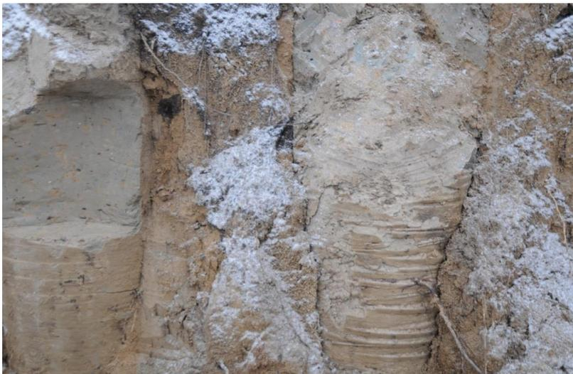
Рис. 4. Фрагмент вскрытого и зачищенного грунтоцементного элемента
